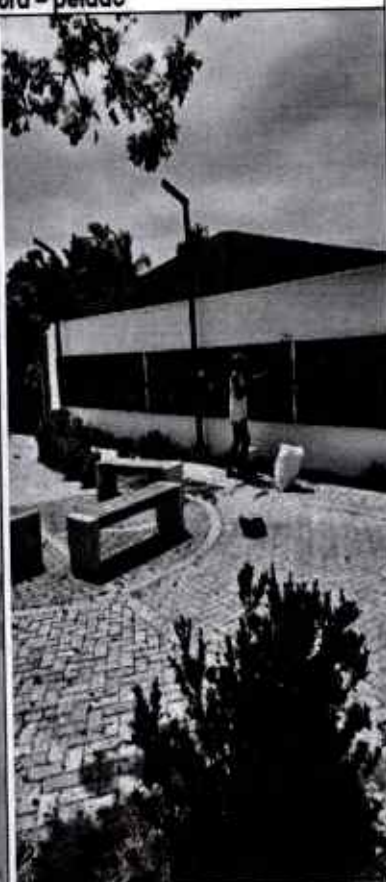
Reparación muro frontal afectado por la pintura
