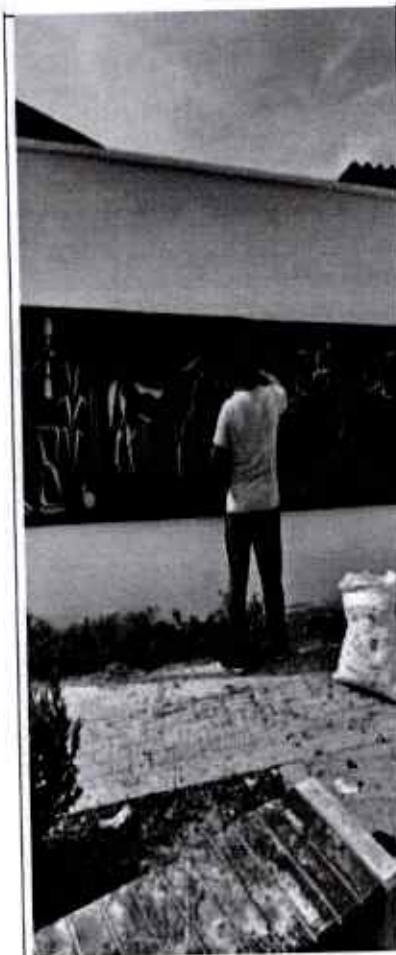
Reparación cinta led eléctrica y laminas arquitectónicas
